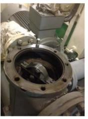
Il filtro della pompa di DR risulta danneggiato per cui si provvede alla sostituzione, eseguita pulizia anche dei due filtri magnetici.
