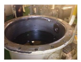
Sostituzione delle guarnizioni e chiusura.
